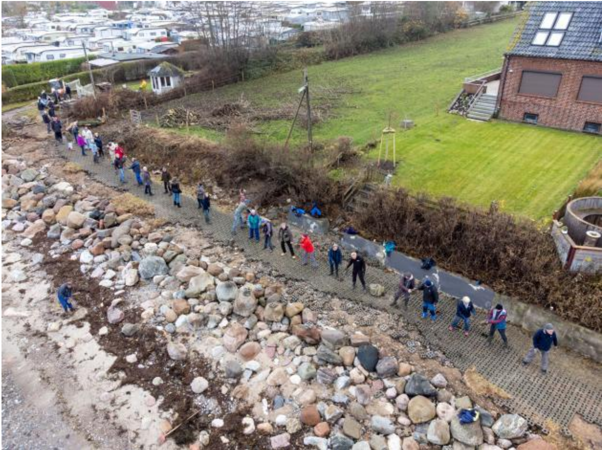
Voller Einsatz in Steinberghaff: Die Rasengittersteine werden aufgenommen und weitergereicht. FOTO: JÖRG KASISCHKE
